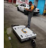
Uso de GPR para localización de tuberías
